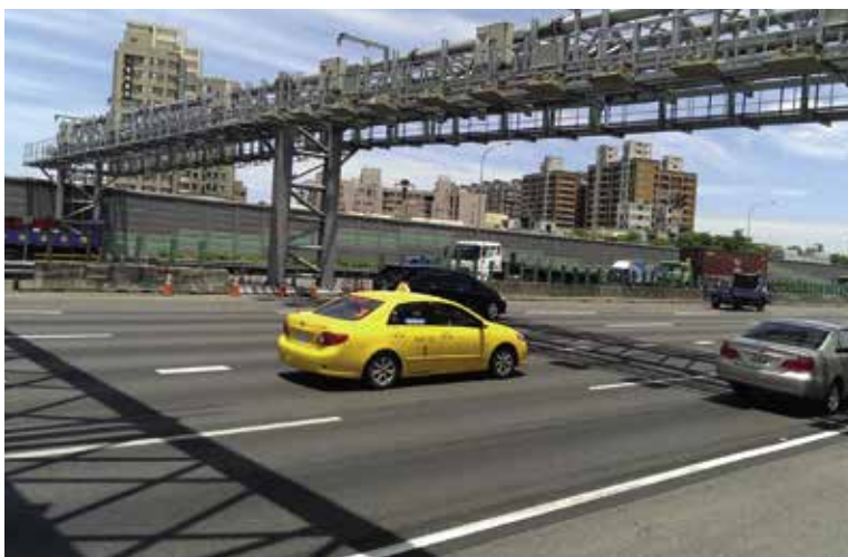
Taïwan a mis en place un péage 100 % électronique sur l'ensemble de son réseau autoroutier.
